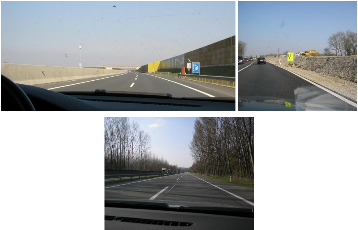
Рисунок А.12 – Щебенево-мастикове асфальтобетонне покриття на дорозі Відень-Ваймар (Австрія)
