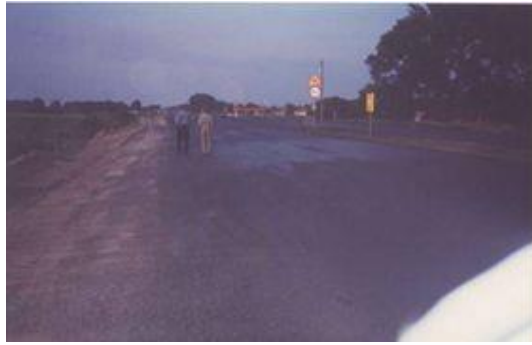
Рисунок А.15 – Бітумні плями на покритті із ЩМА при перевірці технології і рецептів ЩМА-20 на початку апробації в ШРБУ-41 з метою наступного впровадження на автомобільній дорозі Київ-Бориспіль
