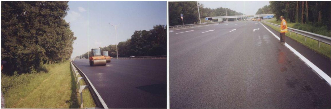
Рисунок А.21 – Стан покриття із ЩМА після завершення влаштування
