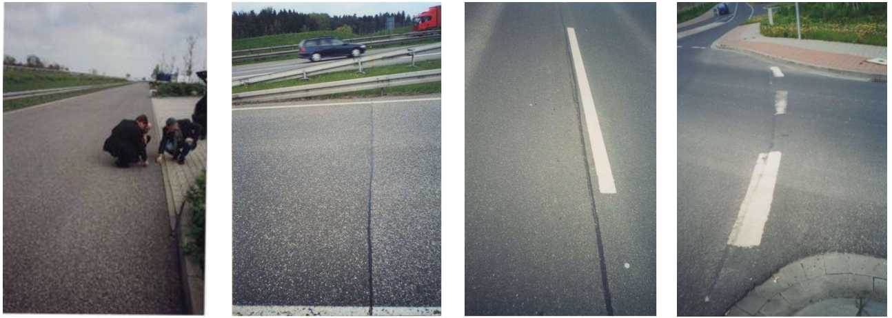
Рисунок А.10 – Щебенево-мастикове асфальтобетонне покриття на автомобільній дорозі Берлін – Варшава (з'їзд на дорогу місцевого значення), Німеччина
