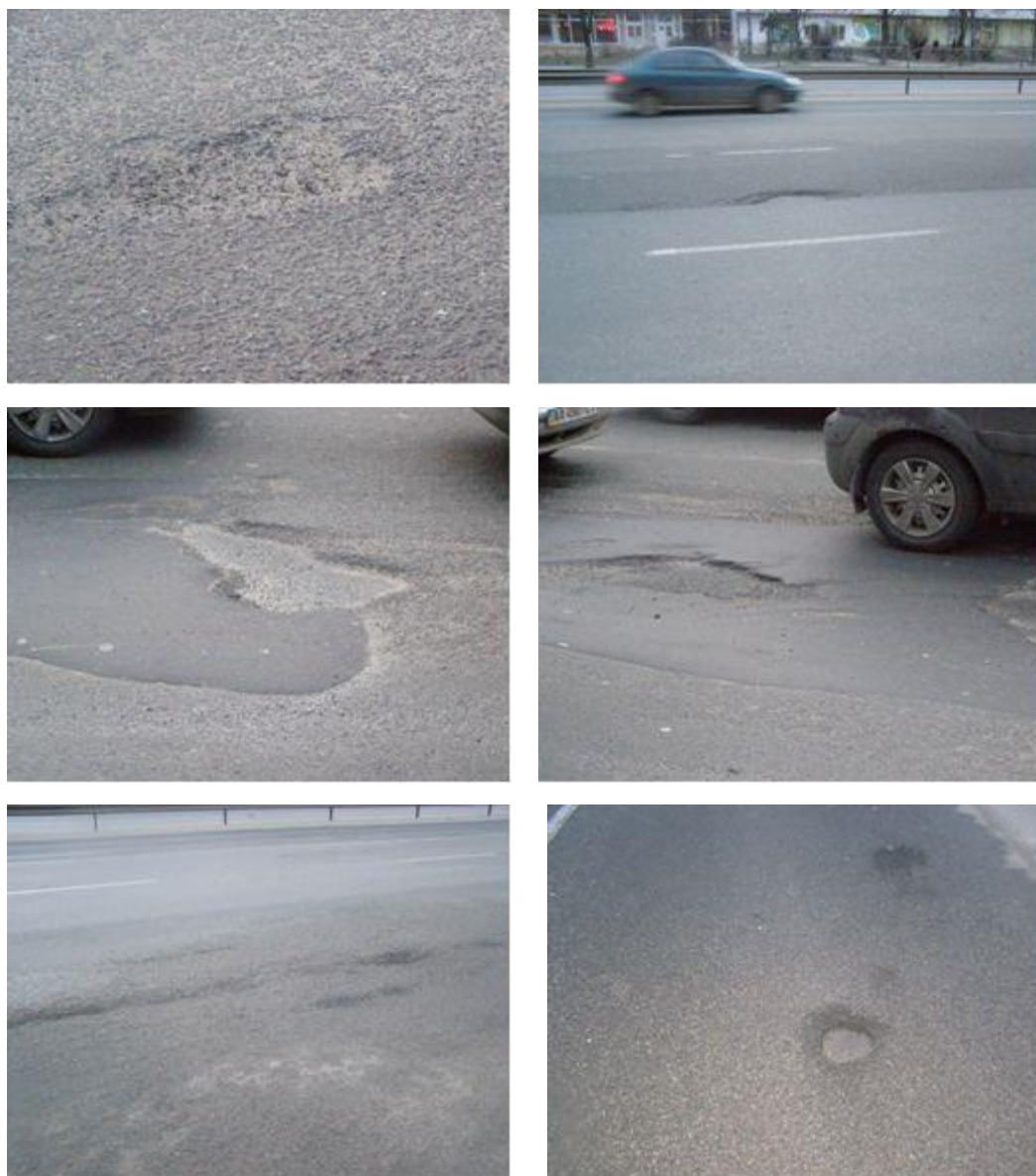
Рисунок А.1 – Викришування та вибоїни
