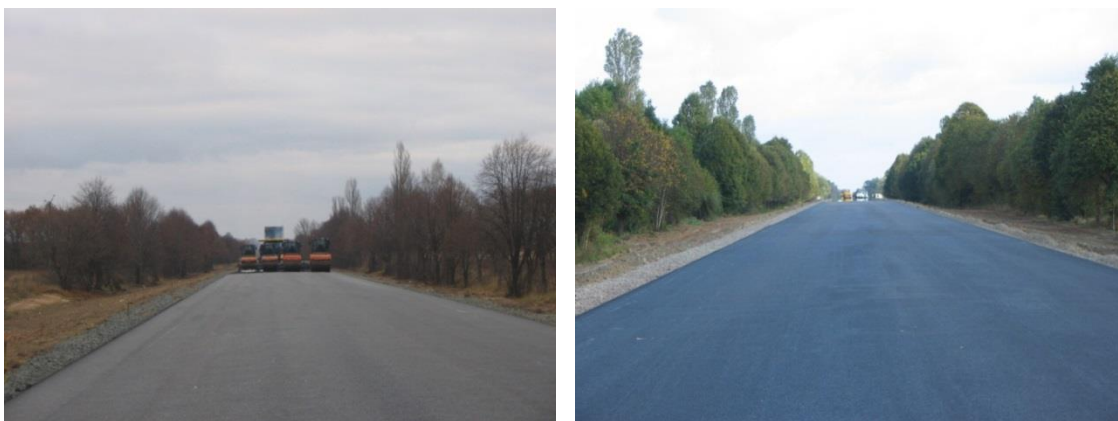
Рисунок А.24 – Стан ЩМА на автомобільній дорозі Кіпті-Глухів-Бачівськ, дальність транспортування складає приблизно 110 км
