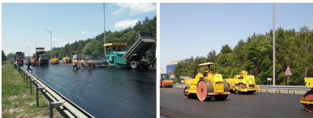
Рисунок А.20 – Влаштування покриття із щебенево-мастикового асфальтобетону на автомобільній дорозі Київ – Бориспіль (2004 р.)
