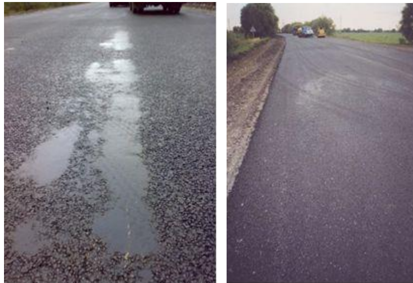
Рисунок А.14 – Приклади плям на поверхні покриття із ЩМА
