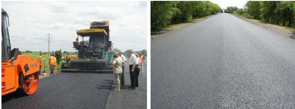
Рисунок А.19 – Результати позитивного відпрацювання рецептів та влаштування покриття із щебенево-мастикового асфальтобетону на північно-східному обході м. Київ
