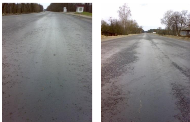
Рисунок А.25 – Стан ЩМА на автомобільній дорозі Кіпті-Глухів-Бачівськ, дальність транспортування складає приблизно 160 км
