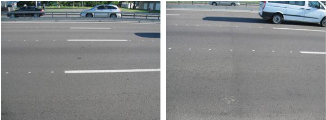
Рисунок А.26 – Стан ЩМА на проспекті Бажана в м. Києві біля ст. метро «Вирлиця», дальність транспортування складає приблизно 65 км
