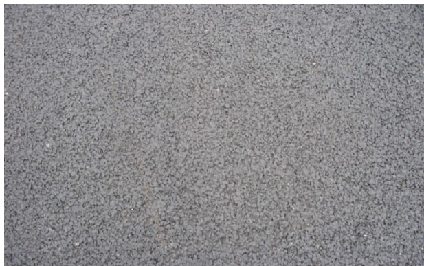
Рисунок А.23 – Влаштування покриття із щебенево-мастикового асфальтобетону на вул. Хрещатик в м. Києві (2005 р.)
