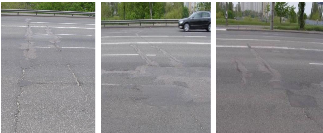
Рисунок А.6 – Стан асфальтобетонного покриття на проспекті Воз'єднання в м. Києві
