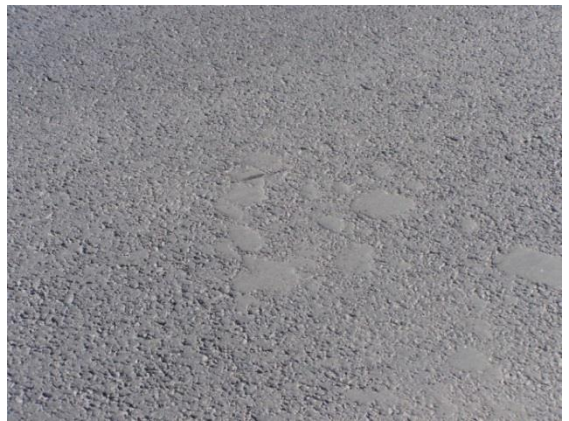
Рисунок А.28 – Стан ЩМА на проспекті Бажана в м. Києві біля ст. метро «Осокорки» дальність транспортування складає приблизно 78 км
