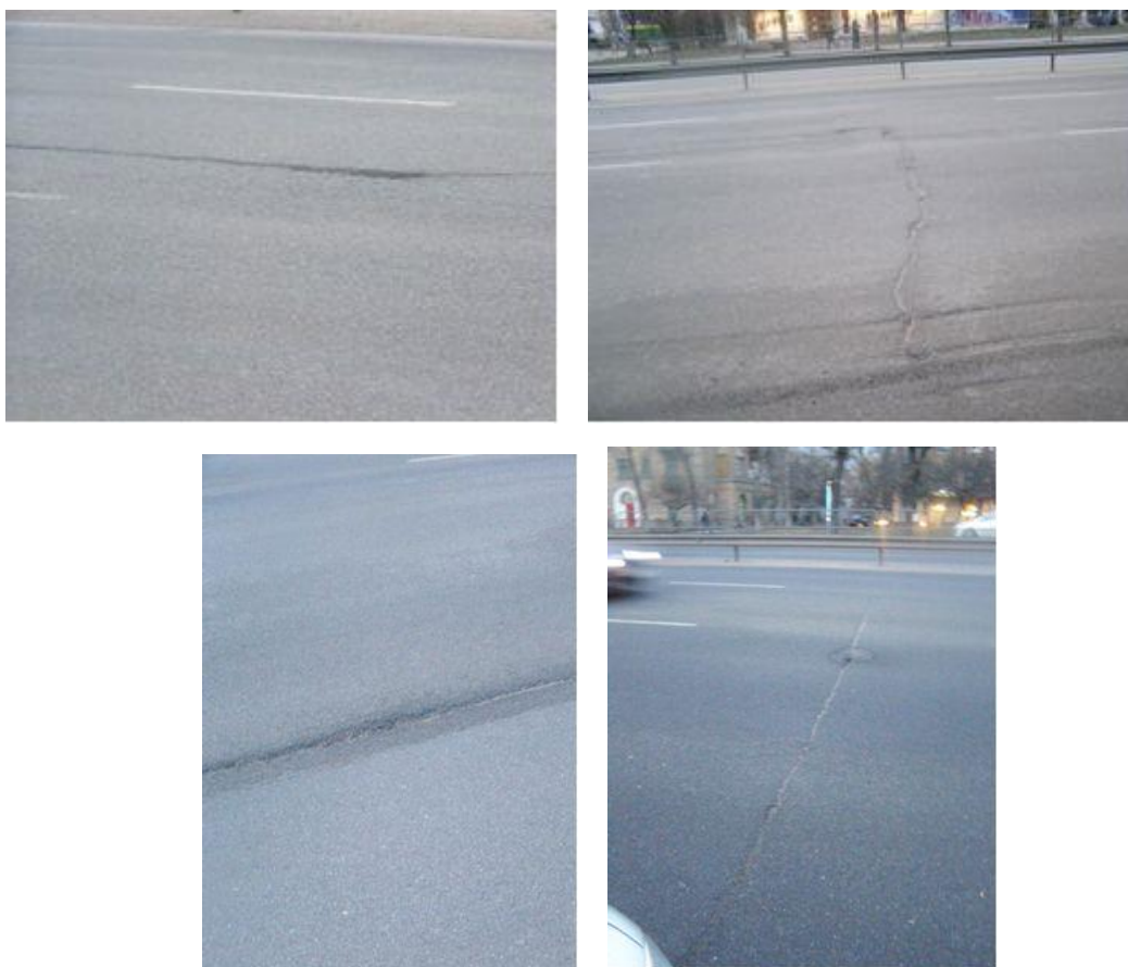
Рисунок А.4 – Поперечні та поздовжні тріщини
