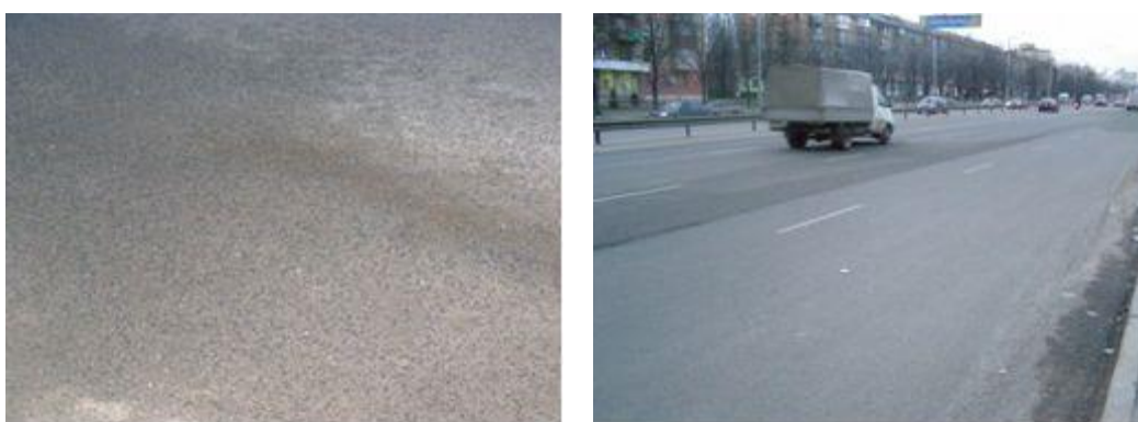
Рисунок А.3 – Шелушіння покриття
