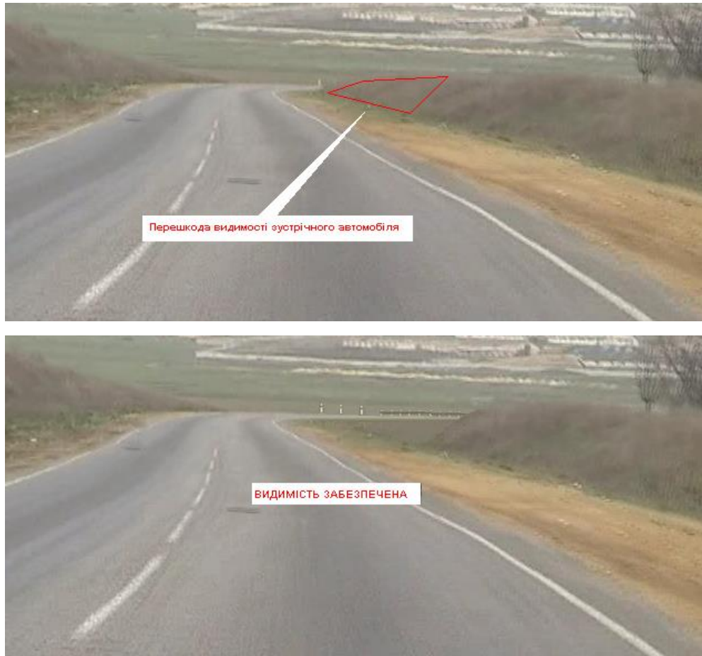
Рисунок 2.7 – Приклад невиявленої обмеженої просторової видимості на ділянці автомобільної дороги ( R=1000 м, похил - 7\text{‰} )
