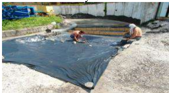
Рисунок Д.20 – Накриття щебеневої основи на секторах 6-10 поліетиленовою плівкою перед заливкою бетонною сумішшю
