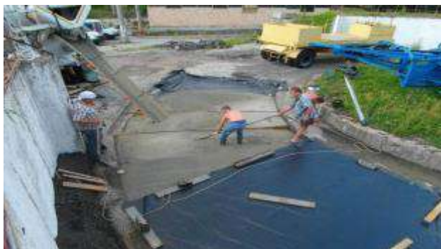
Рисунок Д.23 – Укладання бетонної суміші на 6-10 секторах
