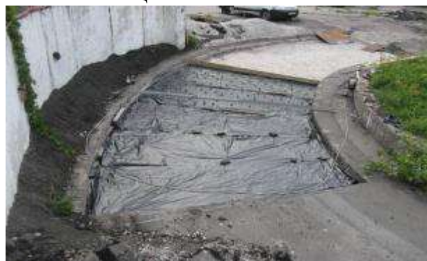
Рисунок Д.14 – Армуюча базальтова сітка на секції 4
