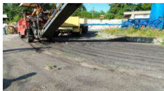
Рисунок Д. 4 – Вигляд дослідної ділянки після фрезування
