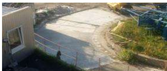
Рисунок Д.26 – Вигляд готової бетонної основи після набору міцності
