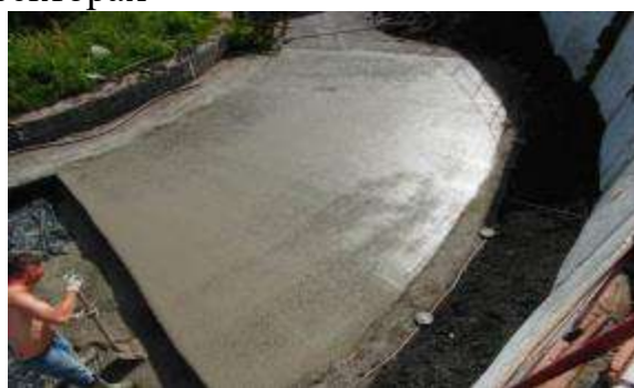
Рисунок Д. 18 – Вигляд бетонної поверхні на секторах 1- 5 після закінчення її планування
