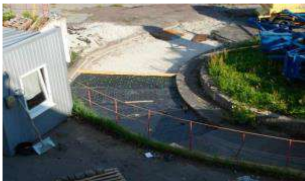
Рисунок Д.15 – Армуюча базальтова сітка на секції 4
