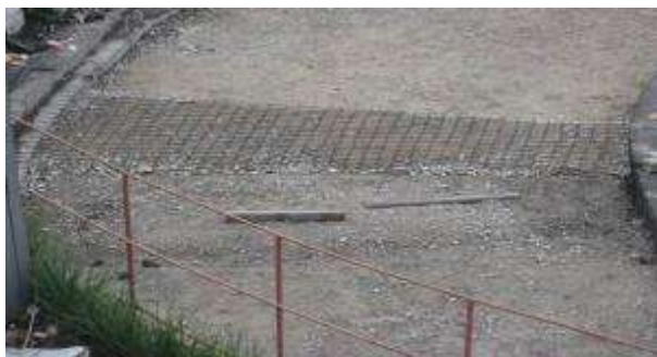
Рисунок Д.11– Армуюча базальтова сітка на секції 4
