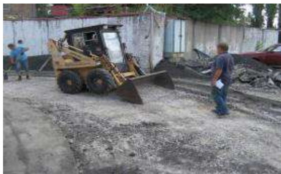
Рисунок Д.8 – Видалення матеріалів старого покриття бабкетом
