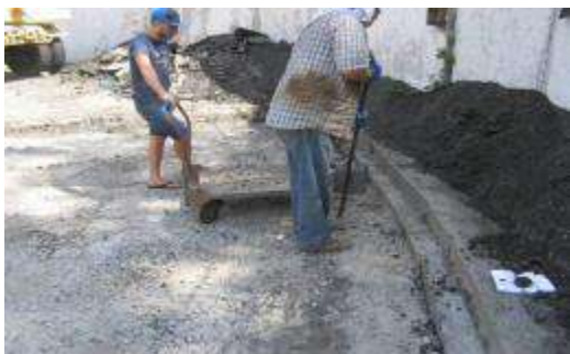
Рисунок Д. 7 – Поглиблення корита до заданої відмітки
