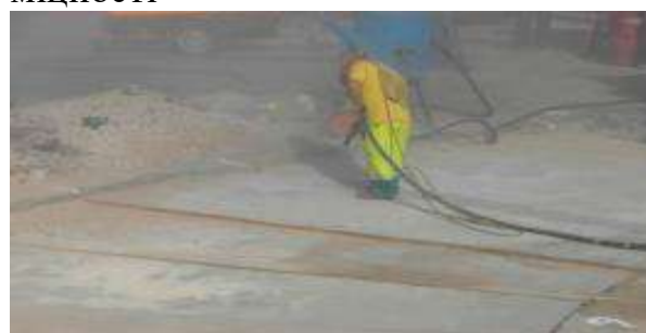
Рисунок Д.28 – Видалення цементного молока пешано-струйним методом
