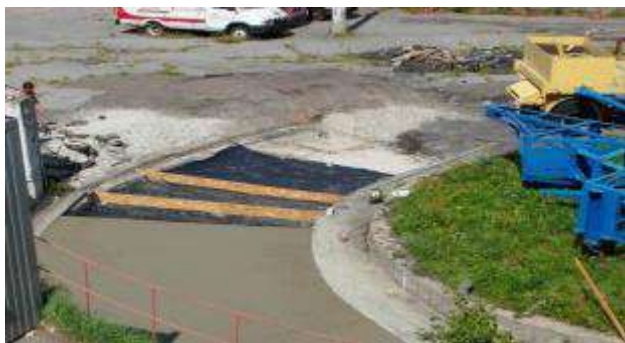
Рисунок Д.21 – Перегородки між секторами
