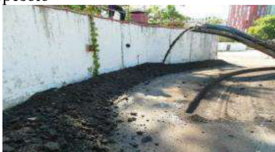
Рисунок Д. 3 – Складування матеріалів фрезування асфальтобетонного шару старого покриття
