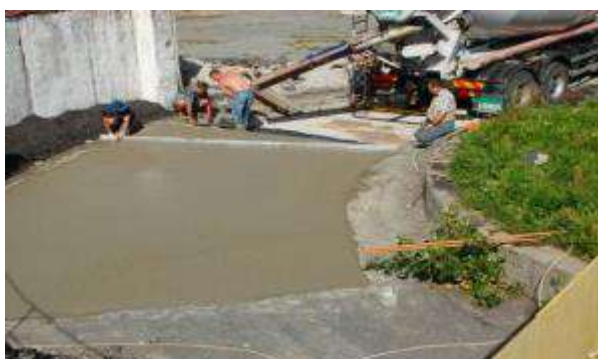
Рисунок Д. 17 – Перевірка рівності поверхні цементобетонного покриття на 5-му секторі
