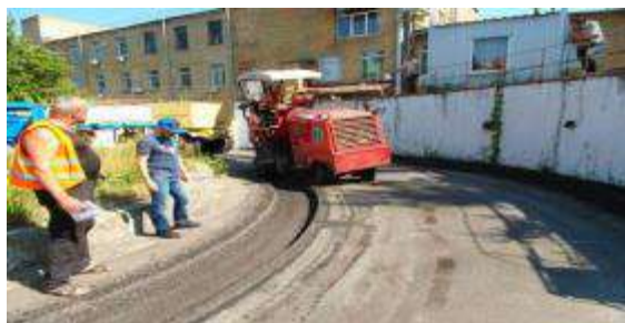
Рисунок Д. 1 – Зняття верхнього шару старого покриття дорожньою фрезою
