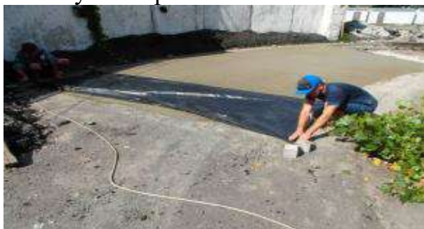
Рисунок Д.19 – Накриття бетонного шару на секторі 1 захистною плівкою
