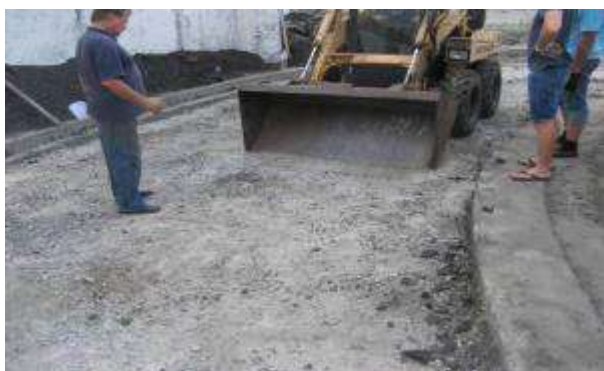
Рисунок Д.9 – Планування корита ковшом бабкета
