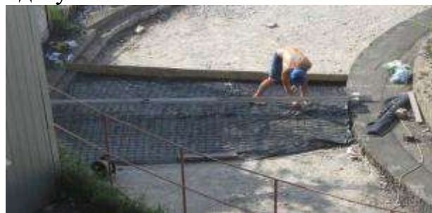
Рисунок Д.12 – Армуюча базальтова сітка на секції 4
