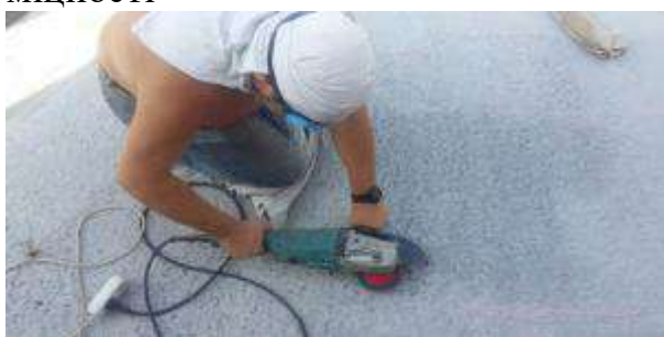
Рисунок Д.27 – Видалення цементного молока на секторі 3
