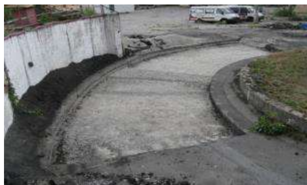
Рисунок Д.10 – Вигляд на корито підготовлене до влаштування експериментальних шарів дорожнього одягу
