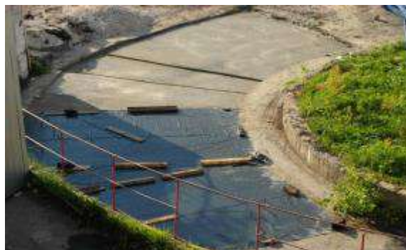
Рисунок Д.24 – Вигляд експериментальних секторів після закінчення укладання бетону
