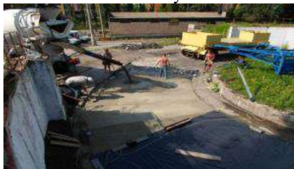
Рисунок Д.22 – Укладання бетонної суміші на 6-10 секторах
