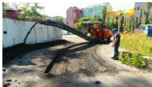
Рисунок Д. 2 – Фрезування покриття паралельними проходами фрези
