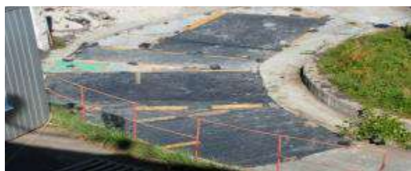
Рисунок Д. 25 – Вигляд секторів під захистною плівкою у процесі набору міцності
