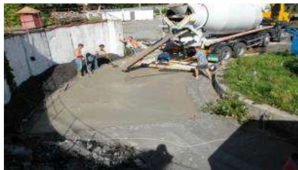
Рисунок Д.16 – Заливка цементобетонною сумішшю на 1-5 секторах
