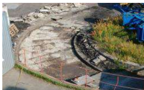
Рисунок Д. 6 – Вигляд експериментальної ділянки після видалення старого асфальтобетонного покриття
