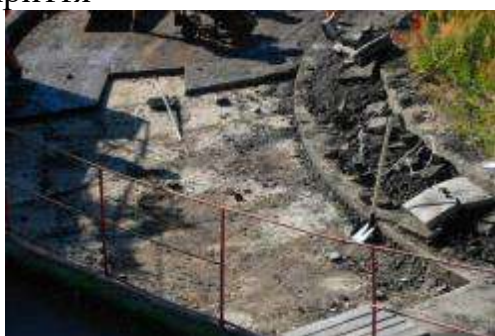
Рисунок Д. 5 – Розбирання нижнього шару старого асфальтобетонного покриття
