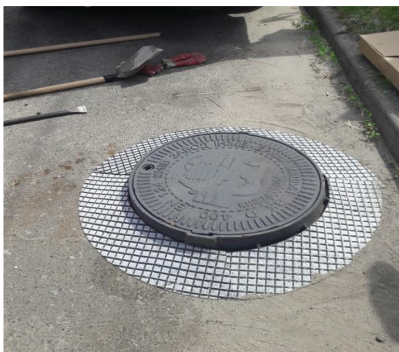
Рисунок Б.12 – Армуюча геогратка Adfors GlasGrid® PM100. Зовнішній вигляд
