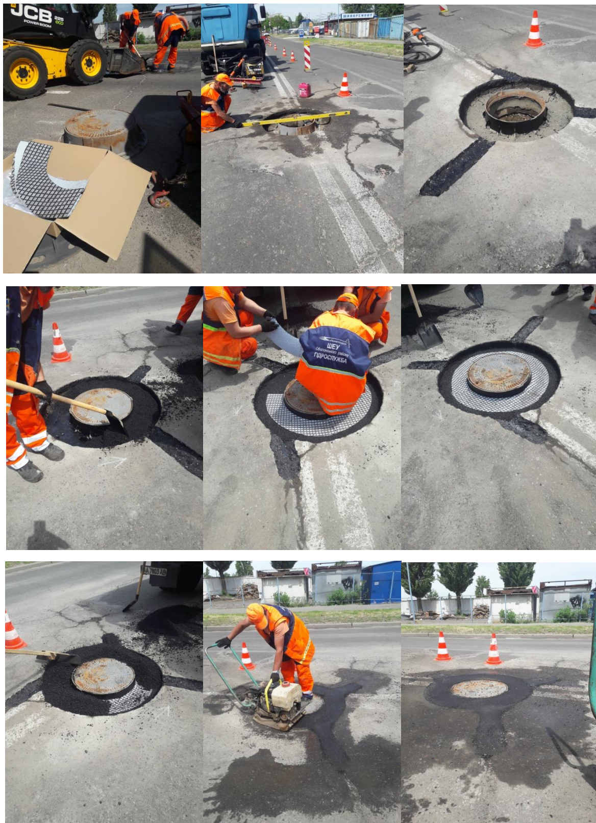
Рисунок Б.14 – Ремонт каналізаційного люку з застосуванням армуючої геогратки Adfors GlasGrid® PM100 (Оболонський район м.Києва, травень 2019 року)
