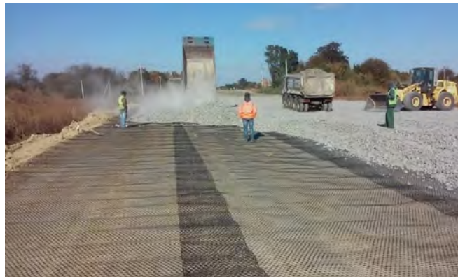
Рисунок 2.1 – Влаштування багатовісноорієнтованої геогратки Tensar TriAx
