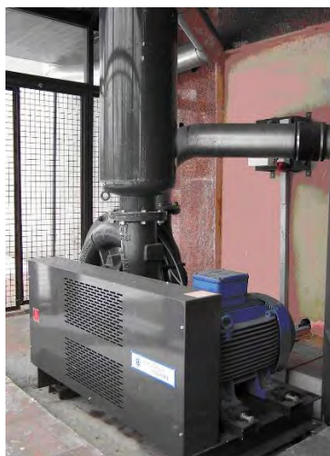
Рисунок А.6.2 – Вакуумний насос CVS та шафа з частотним потоку фірми Veris, що перетворювачем для управління ним використовується
