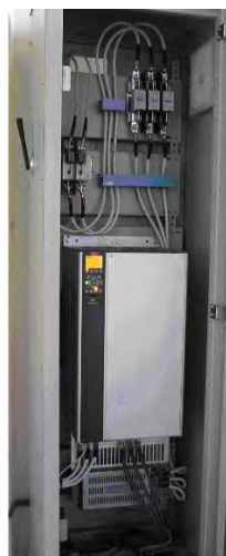
Рисунок А.6.2 – Вакуумний насос CVS та шафа з частотним потоку фірми Veris, що перетворювачем для управління ним використовується
