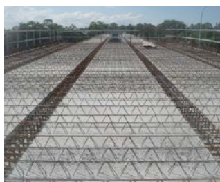
Рисунок 1.15 – Система опалубки HumeSlab: загальний вигляд опалубки перед бетонуванням
