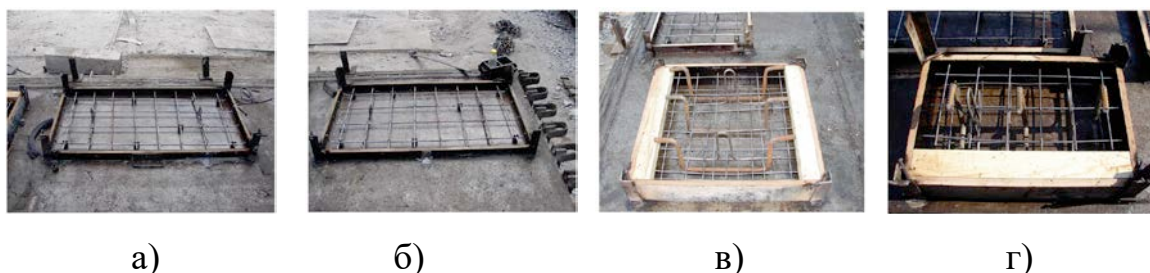
Рисунок 3.11 – Армування збірних елементів
