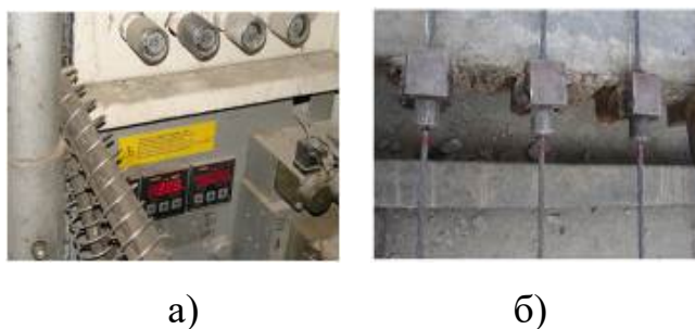
Рисунок 3.15 – Обладнання для натягування канатів
