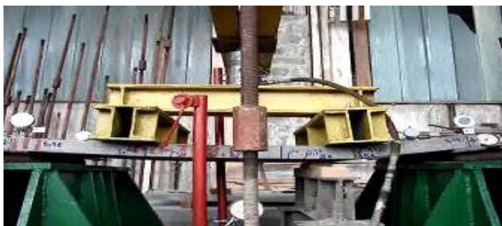
Рисунок 3.34 – Характер руйнувань плити ПО–3
