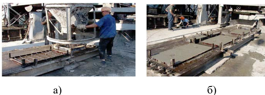
Рисунок 3.12 – Бетонування а) процес бетонування; б) вібрація бетону
