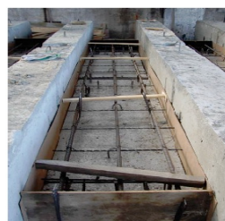
Рисунок 3.20 – Армування зразків плит проїзної частини
