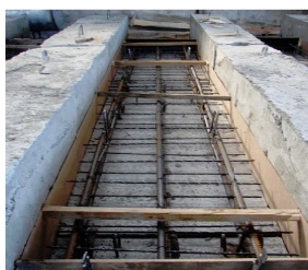
Рисунок 3.20 – Армування зразків плит проїзної частини
