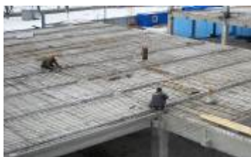
Рисунок 1.13 – Улаштування назнімної опалубки цеху бортового харчування в Міжнародному аеропорту «Бориспіль»
