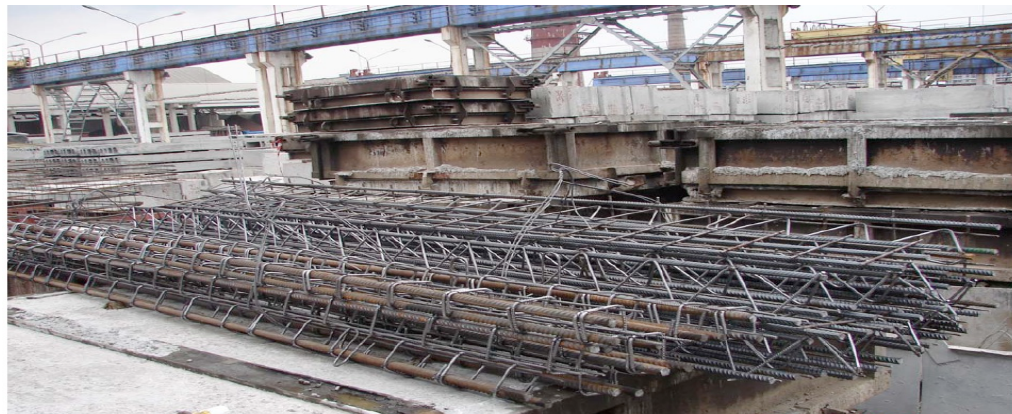
Рисунок 3.16 – Просторові каркаси плит ПО–4 та ПО–5
