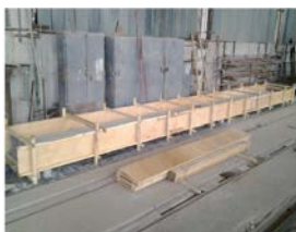
Рисунок 3.24 – Монтаж бокової опалубки плит ПО–5
