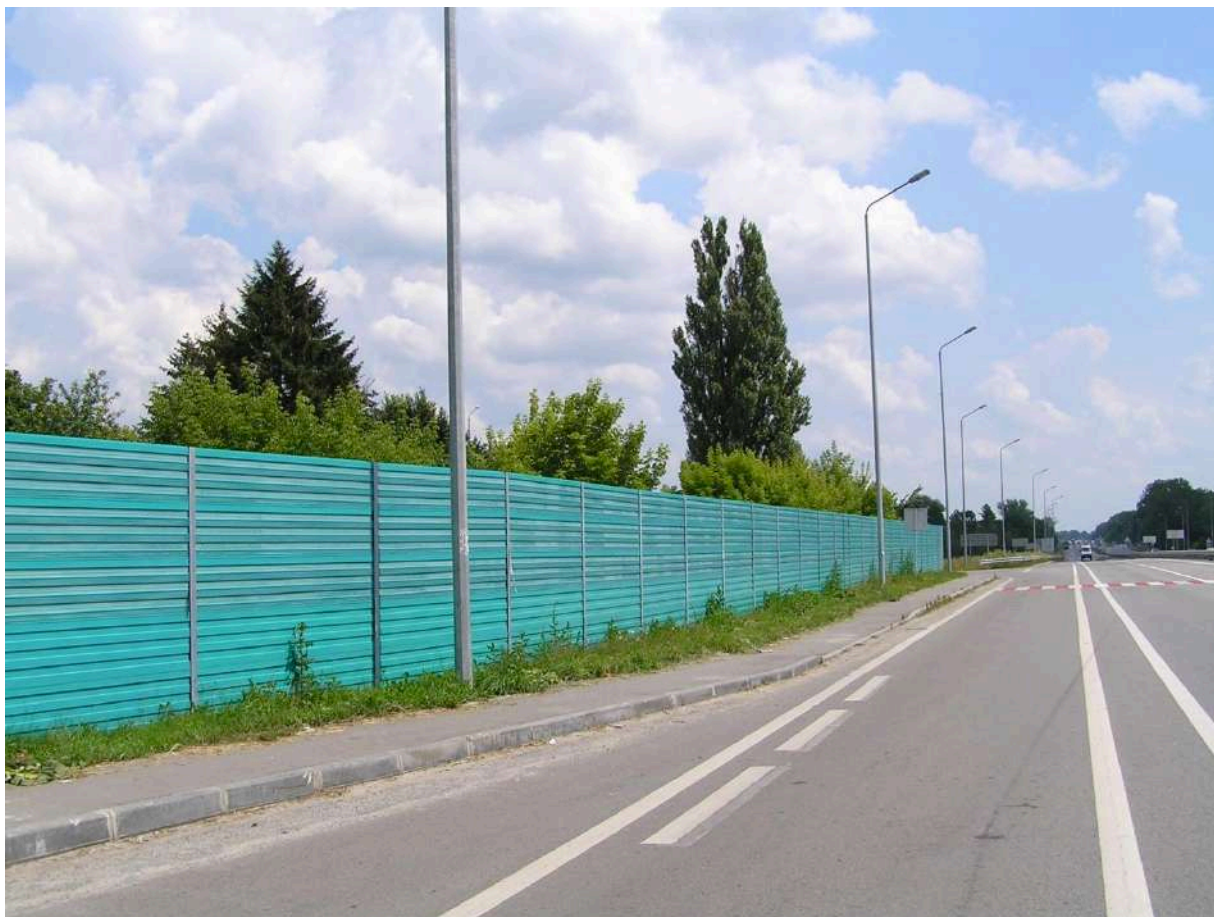
Рисунок 3.1 – Шумозахисні екрани на автомобільній дорозі Київ-Чоп
