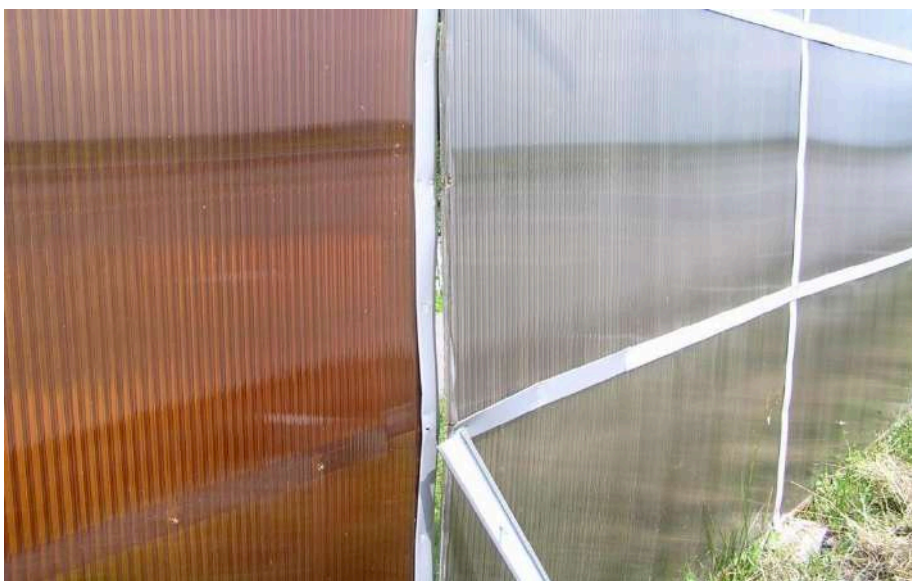
Рисунок 3.7 – Вигинання ШЗЕ під дією негативних впливів довкілля (238 км, Житомирська обл.)
