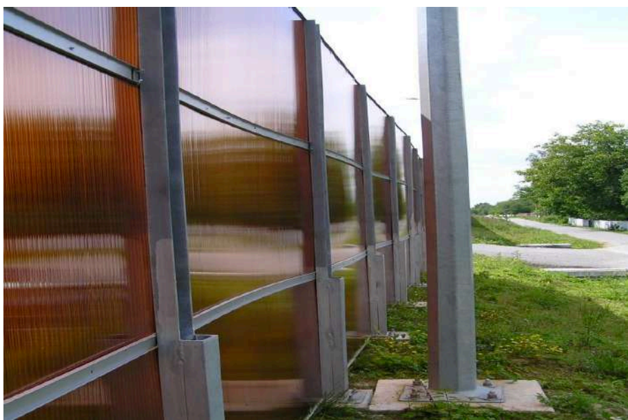
Рисунок 3.7 – Вигинання ШЗЕ під дією негативних впливів довкілля (238 км, Житомирська обл.)
