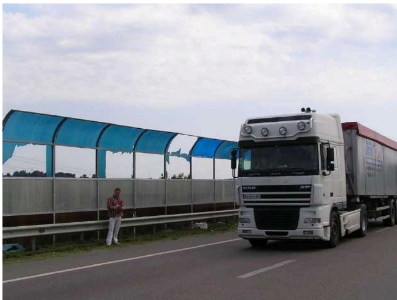
Рисунок 3.9 – Проломи ШЗЕ під дією негативних впливів довкілля (315 км, Рівненська обл.)
