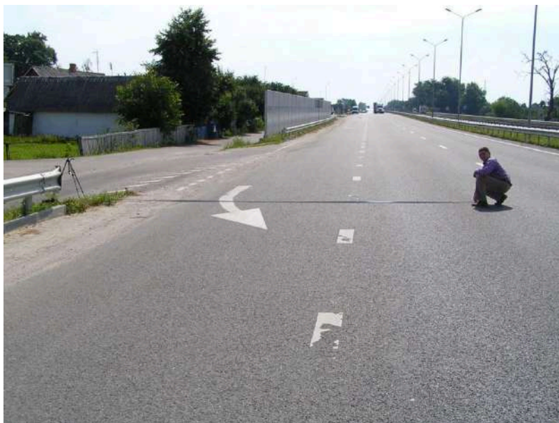
Рисунок 3.11 – Немоżliвість повністю захистити об'єкти за допомогою ШЗЕ через наявність бокової дороги (157 км, с. Березівка, Київська обл.)
