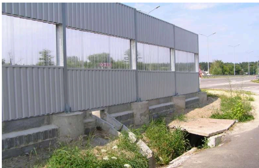
Рисунок 3.16 – Виконання стічного отвору у ШЗЕ
