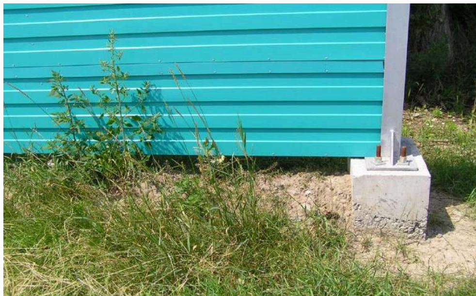
Рисунок 3.14 – Наявність зазору між ШЗЕ і опорною поверхнею, що призводить до зниження акустичної ефективності ШЗЕ (217 км, Київська обл.)
