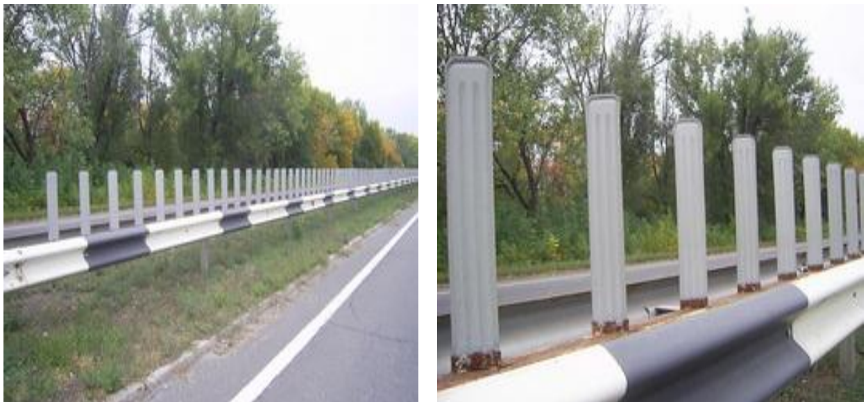
Рисунок 4.8 – Встановлені протизасліплювальні екрани на автодорозі Н-21 Старобільськ – Луганськ – Красний Луч – Макіївка – Донецьк, км 88 + 000 – км 88 + 340 (р-н с. Металіст)
