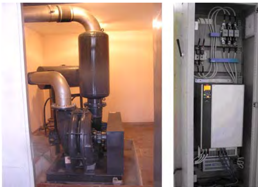
Рисунок 4.10 – Вакуумний насос CVS та шафа з частотним перетворювачем для управління ним.
