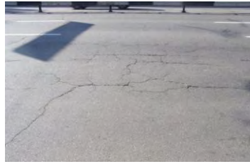
а) Алігаторні розтріскування
