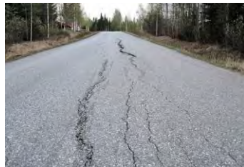
б) Поздовжнє розтріскування
