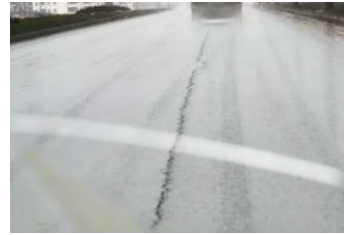
б) Поздовжнє розтріскування
