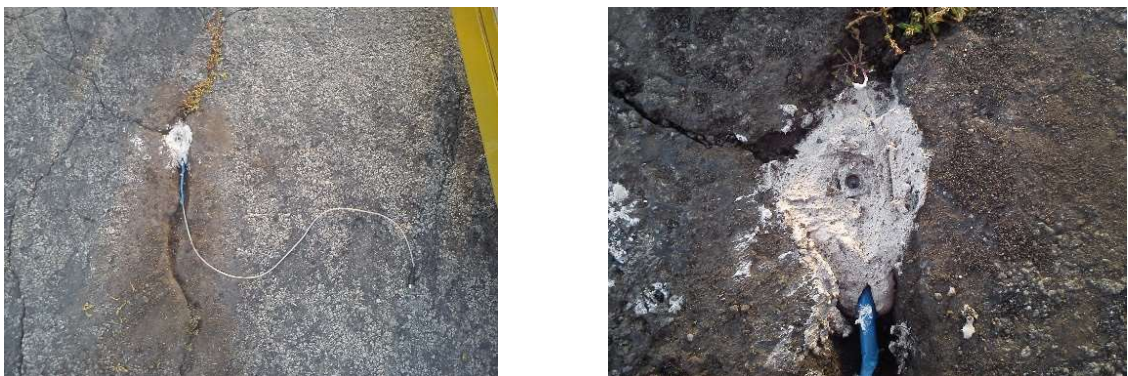
Рисунок 3.6 – Закріплення датчика прискорення в верхньому шарі асфальтобетонного покриття
