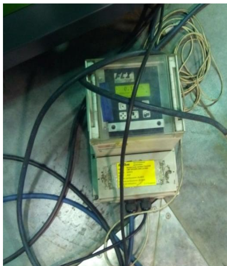
Рисунок 4.5 – Витратомір масових витрат усіх видів рідкого та газового палив FlexCOR
