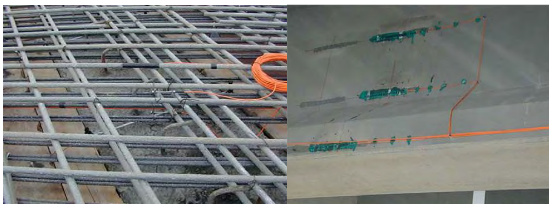
Рисунок 4.12 – Вбудовані оптоволоконні датчики в арматурі та бетонних балках
