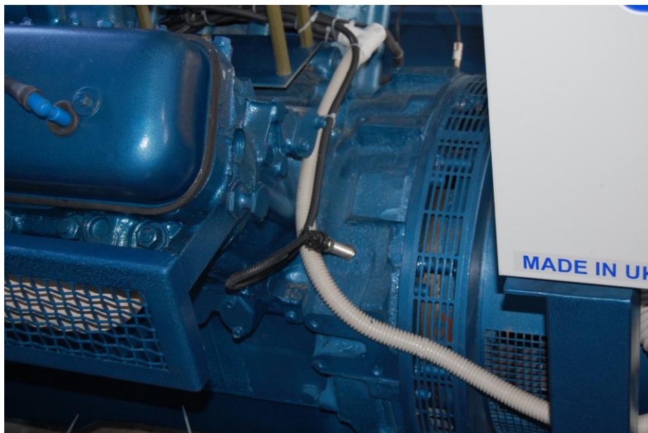
Рисунок 2.7 – Датчик частоти обертання на дизелі
