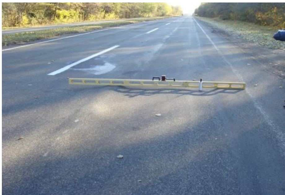
Рисунок 4.6 – Характерні деформації старого покриття – колія
