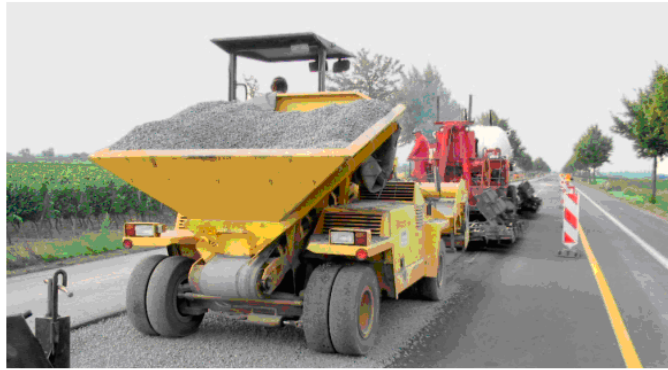
Рисунок 1.4 – Технологічна операція нанесення нових кам'яних матеріалів для коригування складу старого асфальтобетону в технології Remix Plus
