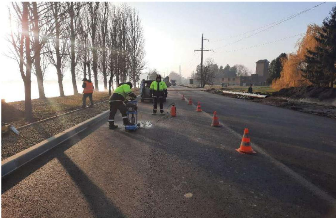
Рисунок 4.9 – Відбирання зразків-кернів на під’їзній автомобільній дорозі до прохідної 1-го блоку ДТЕК Бурштинської ТЕС
