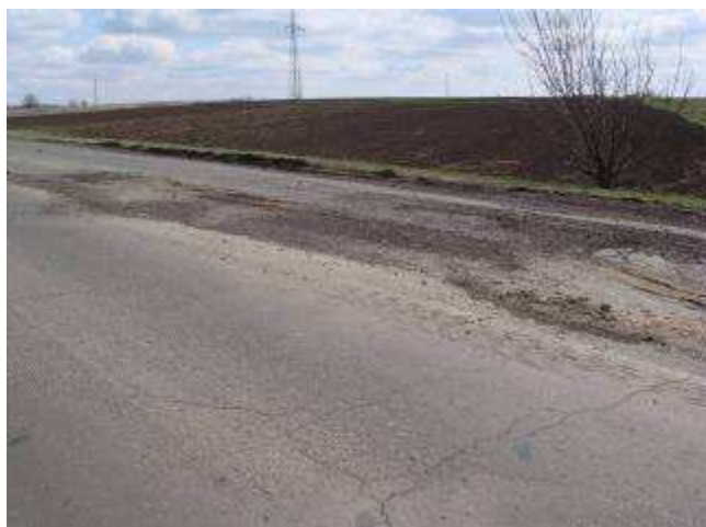
Рисунок 1.2 – Руйнування покриття, спричинені несприятливим водно-тепловим режимом (а/д М-12 Стрий – Тернопіль – Кіровоград – Знам'янка в Кіровоградській області, весна 2012 року)
