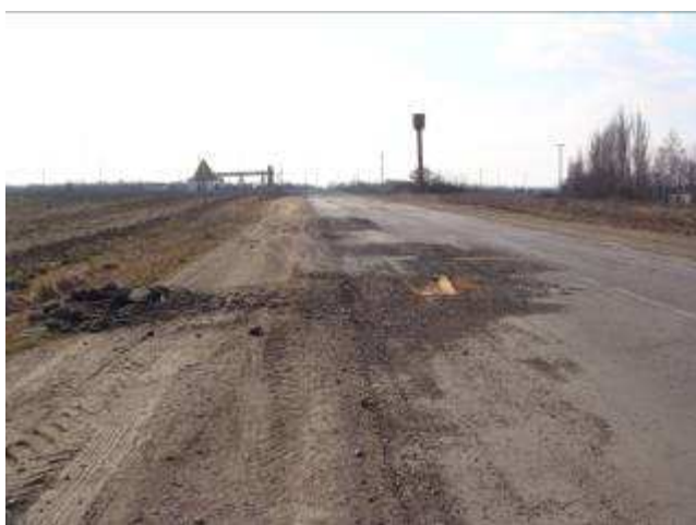
Рисунок 1.2 – Руйнування покриття, спричинені несприятливим водно-тепловим режимом (а/д М-12 Стрий – Тернопіль – Кіровоград – Знам'янка в Кіровоградській області, весна 2012 року)
