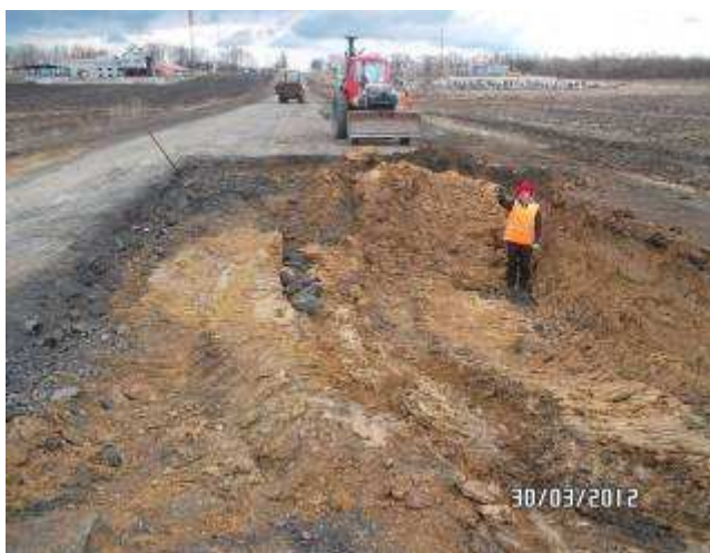
Рисунок 1.3 – Ліквідація руйнувань дорожньої конструкції на а/д М-12 Стрий – Тернопіль – Кіровоград – Знам'янка в Кіровоградській області, весна 2012 року
