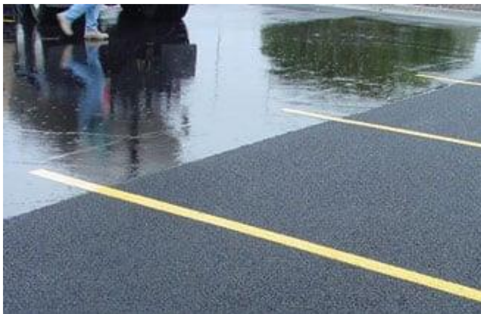
Рисунок 1.1 – Відмінність дренуючих асфальтобетонів від типових щільних
