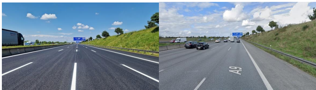
Рисунок 4.3 – Шар зносу пористого асфальтобетону на автомобільному шляху А9 до та після 6 років експлуатації
