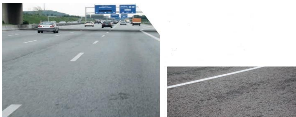
Рисунок 4.4 – Локальне викришування в двох крайніх полосах руху для вантажного транспорту на автомобільному шляху А9 до та після 6 років експлуатації
